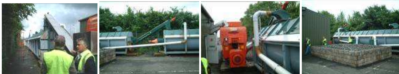
vue des fermenteurs, du système d'alimentation et du biofiltre
